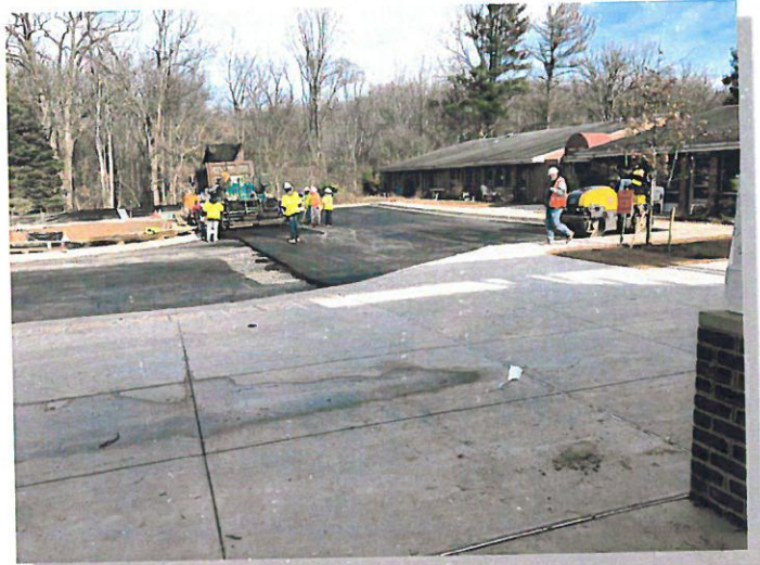
Commons Front Entrance Paving
