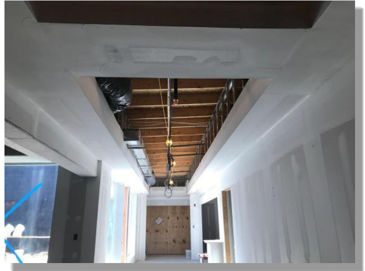
Commons Addition Ceiling Drywall
