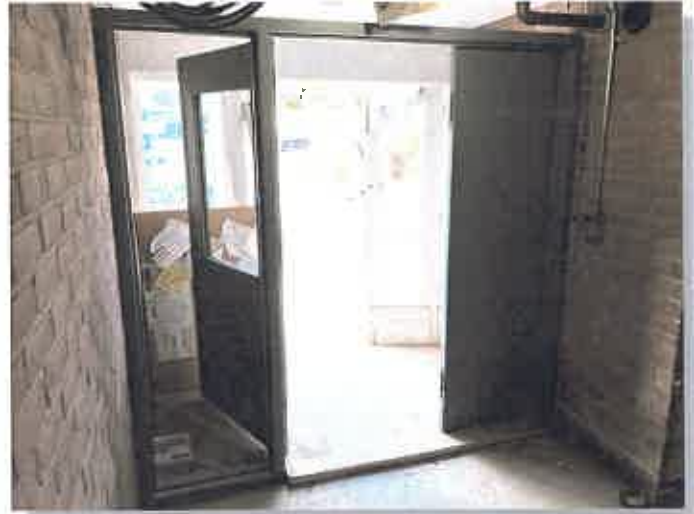
Rear of Commons Exterior Door & Frame
